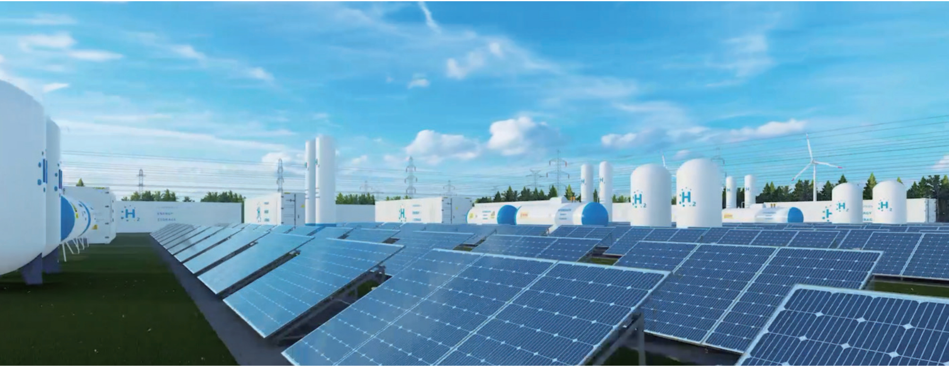
内蒙古鄂尔多斯 40 万千瓦光伏制氢产业示范项目
