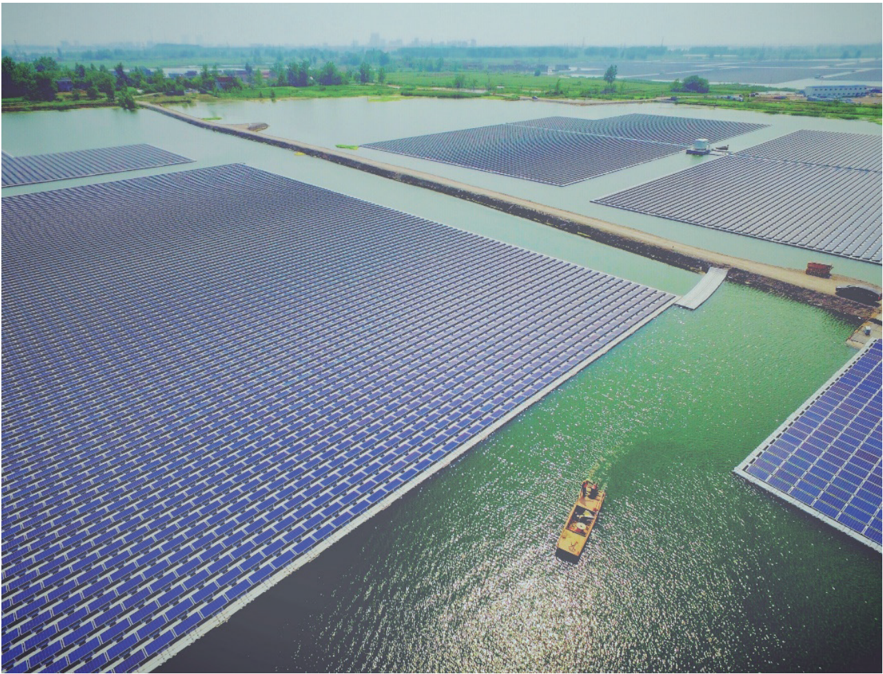
在安徽省淮南市，利用采煤沉陷区闲置水面，建成当期全球领先的水面漂浮光伏电站，项目经受住近 10 年最强暴雪、暴雨等极端天气考验，保持安全稳定运行。
